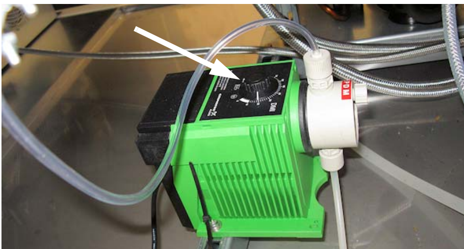
Obr. 5-9 Dávkovací čerpadlo parního zvlhčovače 4)
